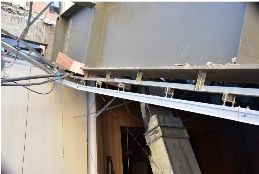
图 12 射灯灯架与主钢梁下翼缘焊接连接
