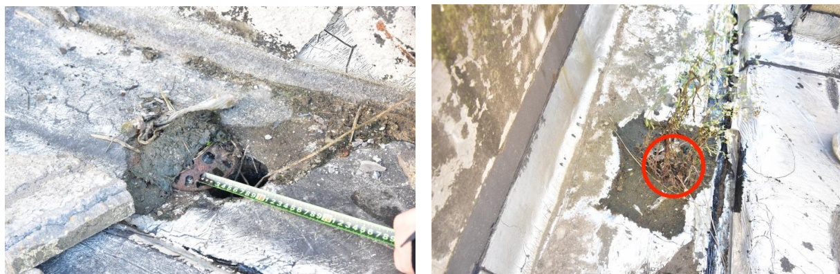
图 10 部分雨水斗堵塞情况
